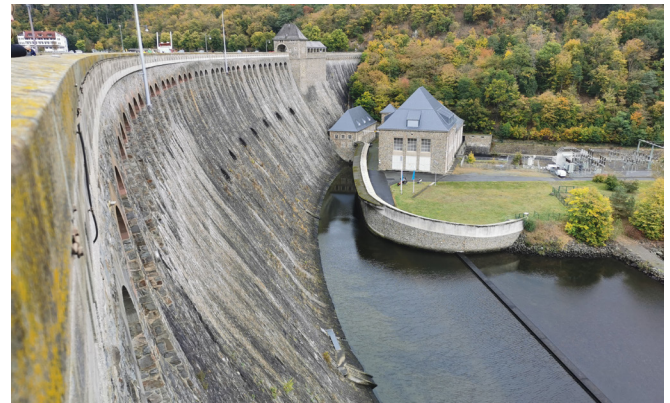
Staumauer des Edersees
